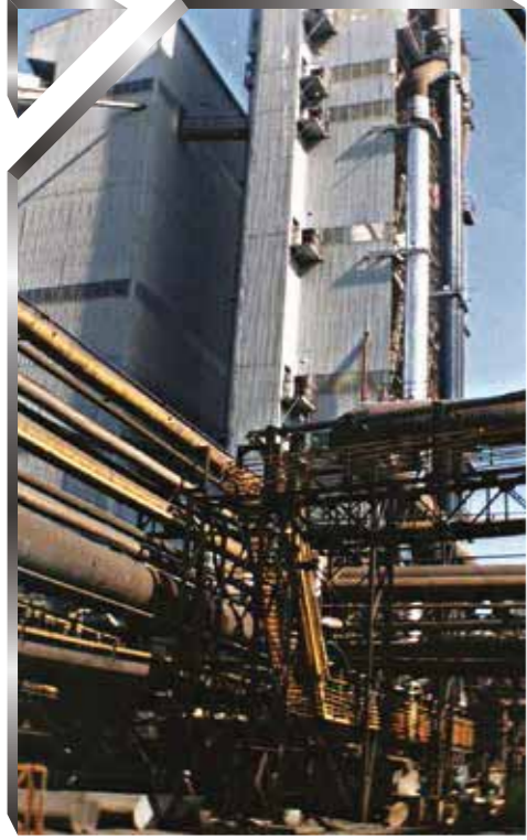
Pulverize Kömür Enjeksiyon Tesisi 2.500 ton Ekipman İmalatı Mühendislik: KAWASAKI - Japonya
