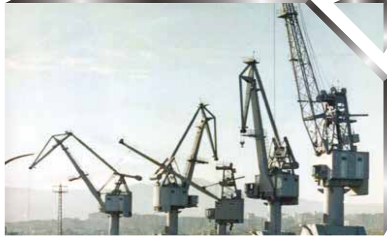
40t Konteyner Vinci İzmir Liman İşletmesi 40t Container Crane İzmir Port Facilities
