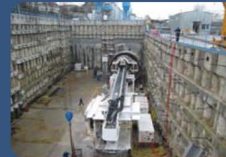
İstanbul Metro İnşaatı Istanbul Metro Construction
