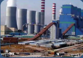
Yumurtalık Termik Santrali Yumurtalık Thermic Power Plant
