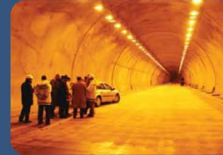
Kağıthane - Piyalepaşa Tüneli Kağıthane - Piyalepaşa Tunnel
